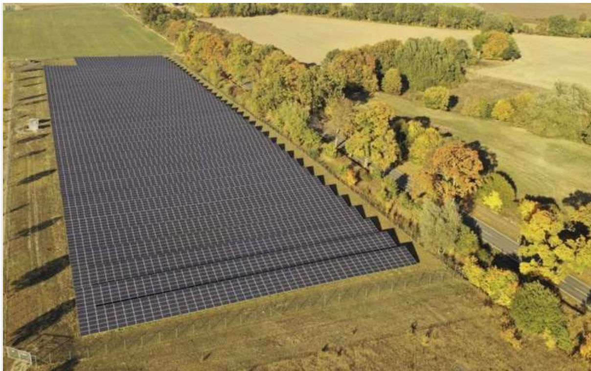
Der Solarpark in Wittstock: Hier stahlen Diebe Ende 2020 über 180 Solarpaneele.
